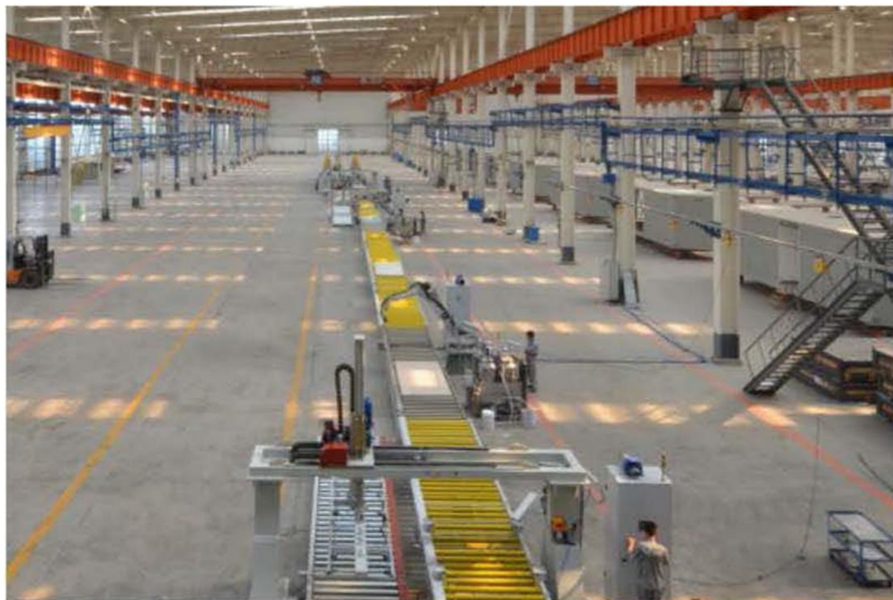
墙板自动化生产线
